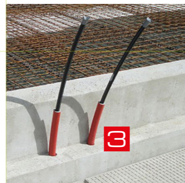
Futtertisch-Aufkantungen vorgebohrt für Installation der Wasserleitungen.
