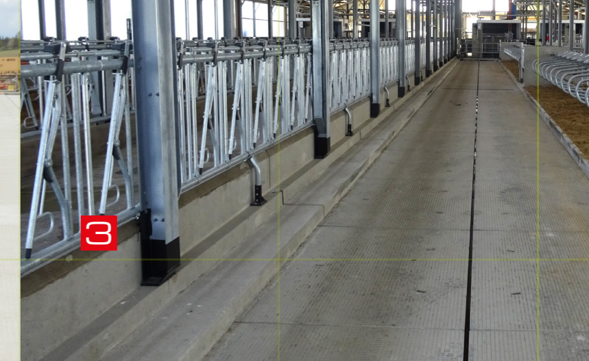
Futtertisch-Aufkantung mit angeschlossenen Antritt für ein entspannteres Fressen.
