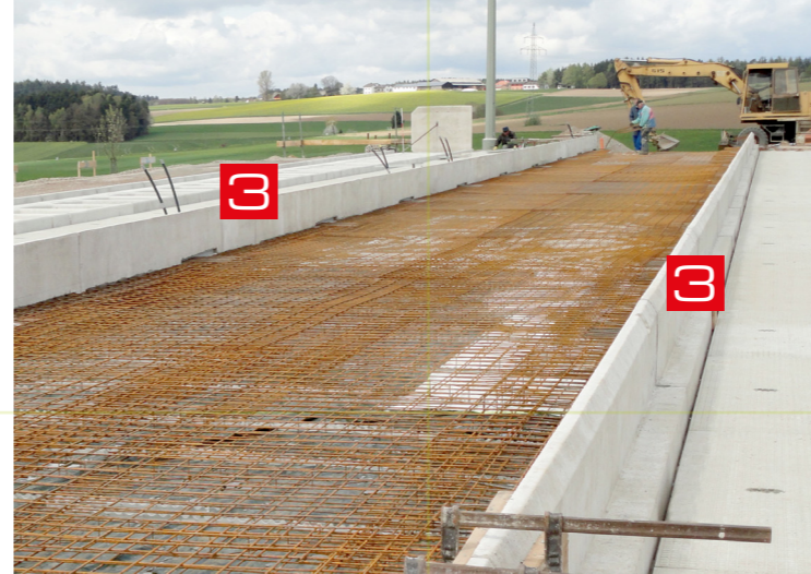
Vorbereitet für den Einbau des Betons der Futtertisch-Durchfahrt. An beiden Längsseiten sind Futtertafelaufkantungen mit Anschluss-Bewehrung eingebaut. Somit sind nahezu keine Schalungsarbeiten erforderlich!
