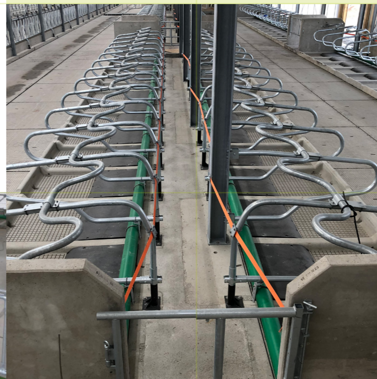
Stalleinrichtung schnell montiert. Einbetonierte Gewindeanker bei den Betonliegmulden und Trogwand-Fertigelementen beschleunigen die Montage der Stalleinrichtung wesentlich.
