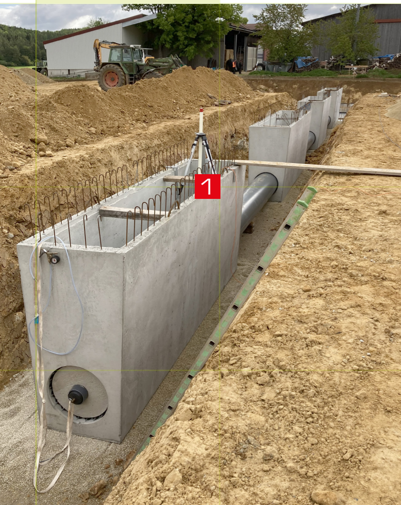
Koteinwurfshächte als Fertigteile für den Querkanal. Wir führen auch gerne die Dichtheitsprüfung nach AwSv-Vorschriften für Sie durch.
