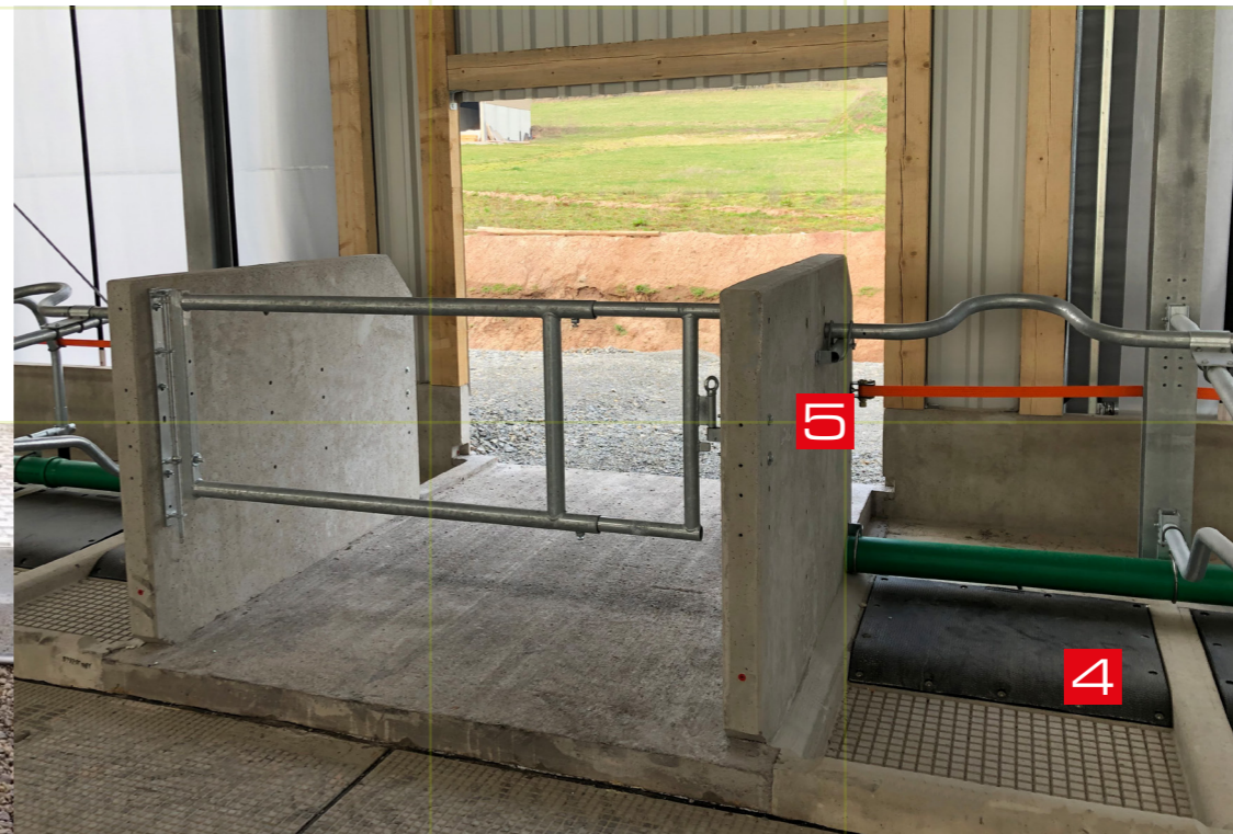
Vorbereitet für den Einbau des Betons der Futtertisch-Durchfahrt. An beiden Längsseiten sind Futtertafelaufkantungen mit Anschluss-Bewehrung eingebaut. Somit sind nahezu keine Schalungsarbeiten erforderlich!
